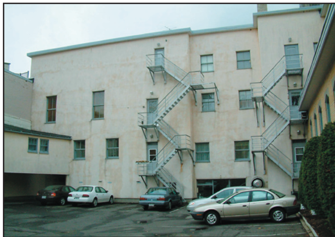
121. Aménagement asphalté, Pères missionnaires du Sacré-Cœur. 108B046.
