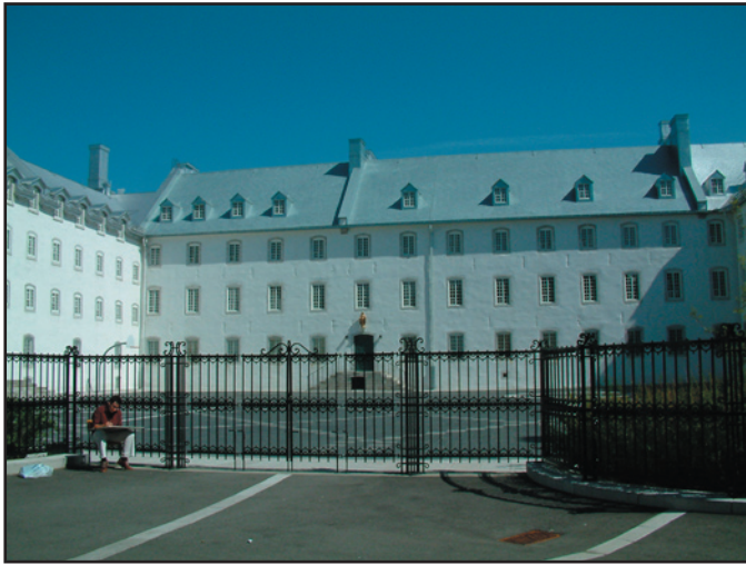
131. La cour intérieure du vieux Séminaire de Québec. 113B013.
