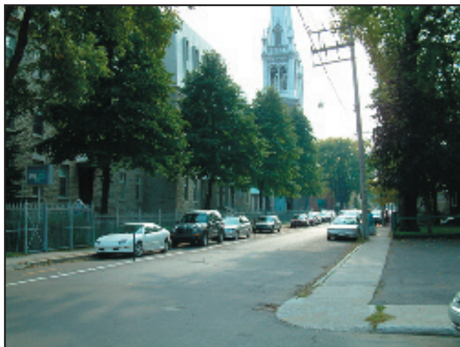
100. Surhaussement du couvent de Limoilou des Sœurs servantes du Saint-Cœur-de-Marie. 602P016.
