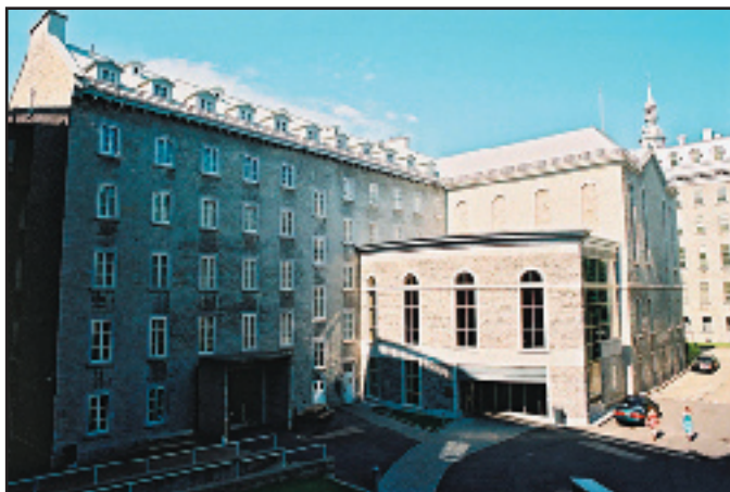
91. Vue du nouveau pavillon du Musée de l'Amérique française. Inscrit à la jonction de l'ancien pensionnat de l'Université et de la chapelle du pensionnat, le volume redouble le corps de bâti, plutôt que de prendre la forme d'une aile additionnelle. 113Z022.
