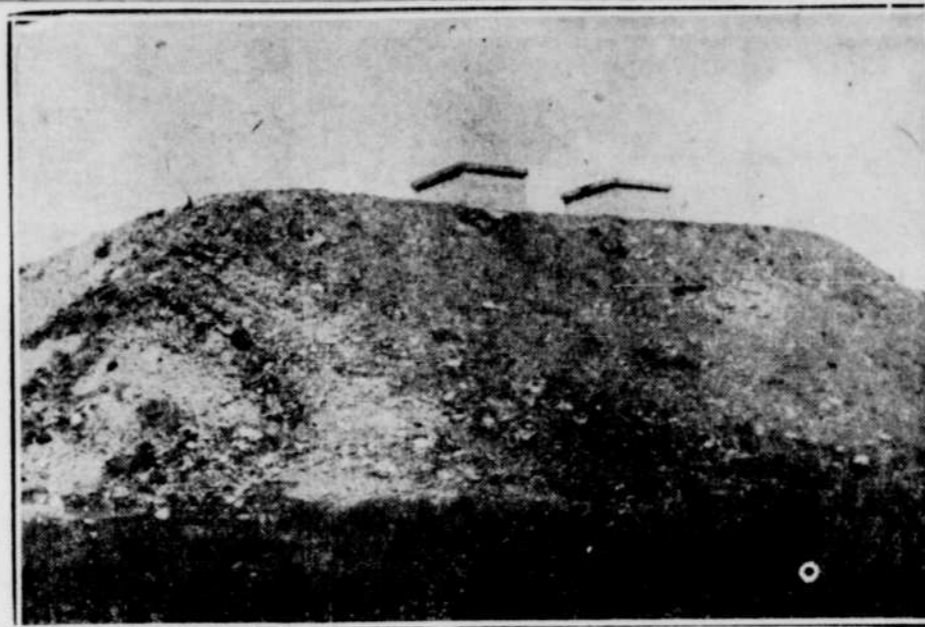
Cette photo nous donne un aperçu du réservoir de 75,000 gallons d'eau érigé à St-Isidore d'Auckland.
