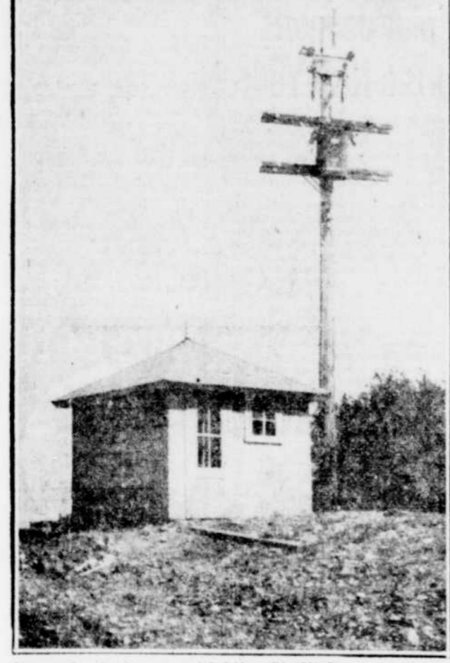
La nouvelle usine de pompage à St-Isidore d'Auckland.
