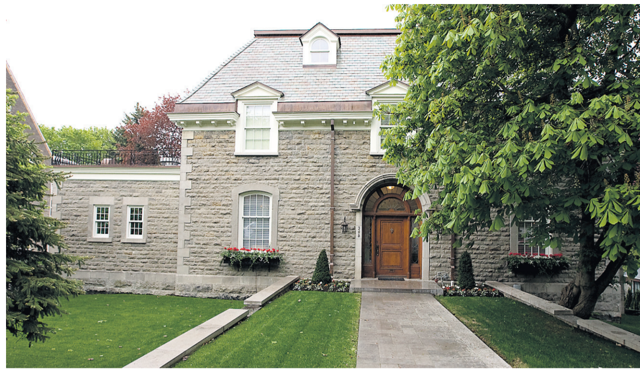
De la pierre véritable habille cette belle de Westmount. Sa toiture est en ardoise.
