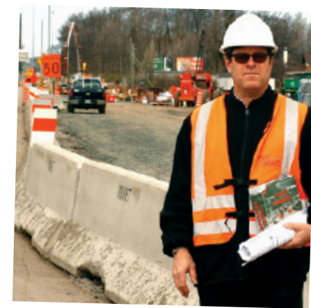
André Laliberté, de la Direction de la région de la Chaudière-Appalaches du ministère des Transports, est surveillant de chantiers routiers. Sa mission : assurer la sécurité des travailleurs et la vôtre!
