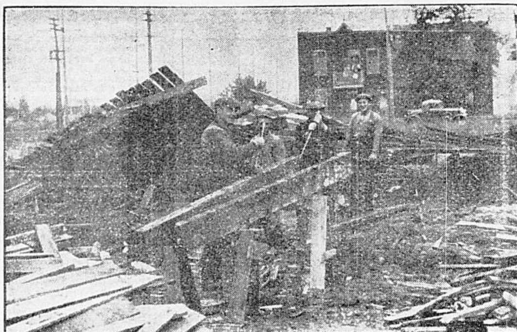
On voit ici des ouvriers procédant au déblaiement des ruines d'une glacière écroulée rue Cadillac, près Hochelaga, lors de l'ouragan de ces jours derniers. (Photo "L'Illustration Nouvelle").
