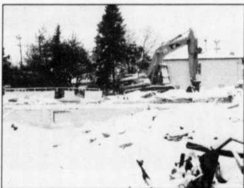
Quatre édifices situés sur le côté sud du boulevard Louis-Frédéric à Nicolet ont été démolis dans les derniers jours. C'est le supermarché IGA qui pourrait utiliser cet emplacement pour assurer son développement futur. Photo Le Courrier Sud
