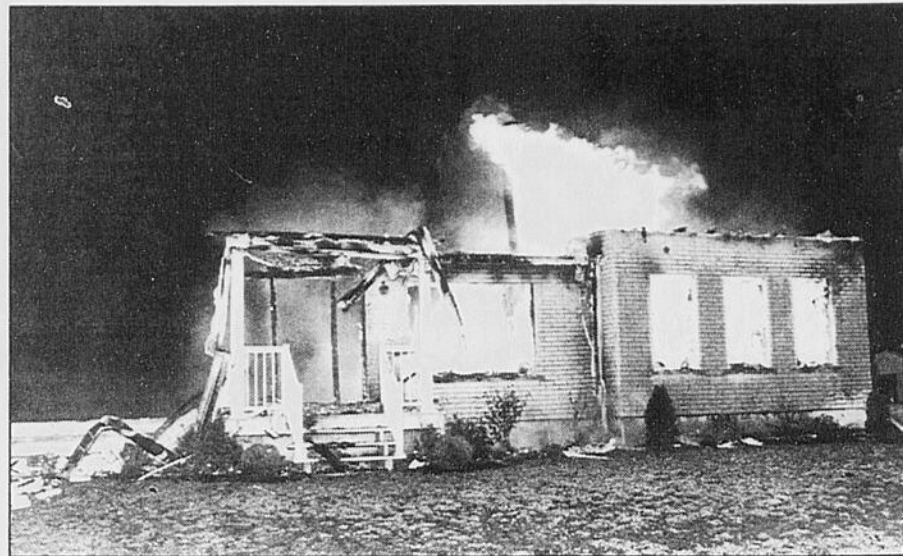
Photo La Tribune par Gilles Besmargian Un incendie a complètement réduit en cendres cette maison et un abri d'auto (sis de l'autre côté), au 1264 route 122 à Saint-Albert-de-Warwick, au cours de la nuit de jeudi et vendredi. Les pertes matérielles sont évaluées à près de 200 000 $.
