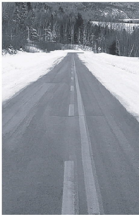
On voit la route partiellement dégagée, après une bordée de neige.
