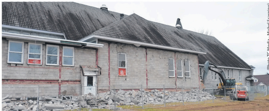
Avant d'aller sous presse, on s'affairait à retirer les pierres du mur extérieur de l'église, signe de la démolition imminente.
