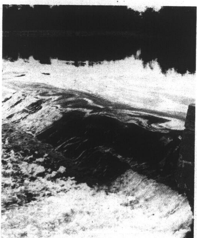
Le barrage-déversoir entre les îles des Moulins et Saint-Jean.
