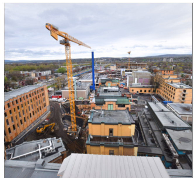
Les travaux préparatoires à la démolition de l'aile D sont commencés.
