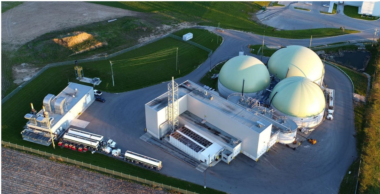
Figure 11 : Photo d'une installation de Bio-En Power
