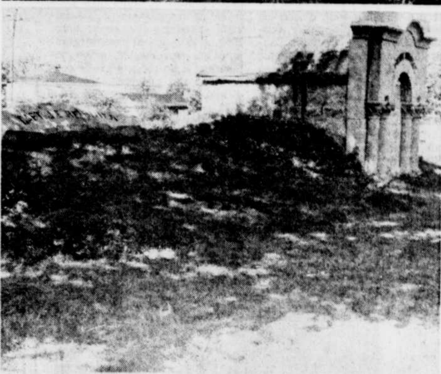
Le mausolée du capitaine J.-E. Bernier, faute d'entretien, est tombé en ruines. La pierre frontale du tombeau sert maintenant de monument au-dessus des tombes enfouies dans le sol du cimetière de Lauzon (photo du haut). Le mausolée que le capitaine avait fait construire était semblable à celui que l'on voit ci-haut à droite, celui de la famille Pierre Bourget.
