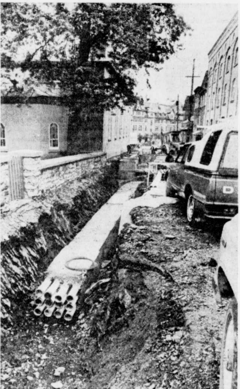
Au coeur du Vieux-Québec, sur la rue Sainte-Anne, la mise en place de puits d'accès et de conduits souterrains a éventré l'étroite artère. Difficile de croire que ce sera chose du passé dans quelques jours...
