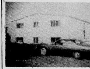
BLOC APPARTEMENT 1545, rue Marc, Mont-Joli
