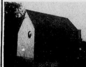
MAISON SOLAIRE 338, Bois-Joli, Pointe-au-Père
