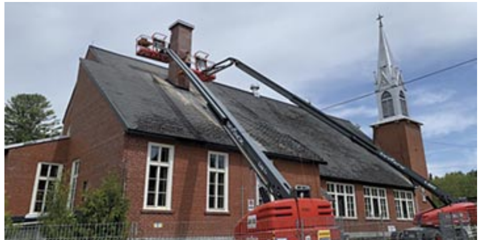
L'église de Saint-Hippolyte durant les travaux de réfection.
