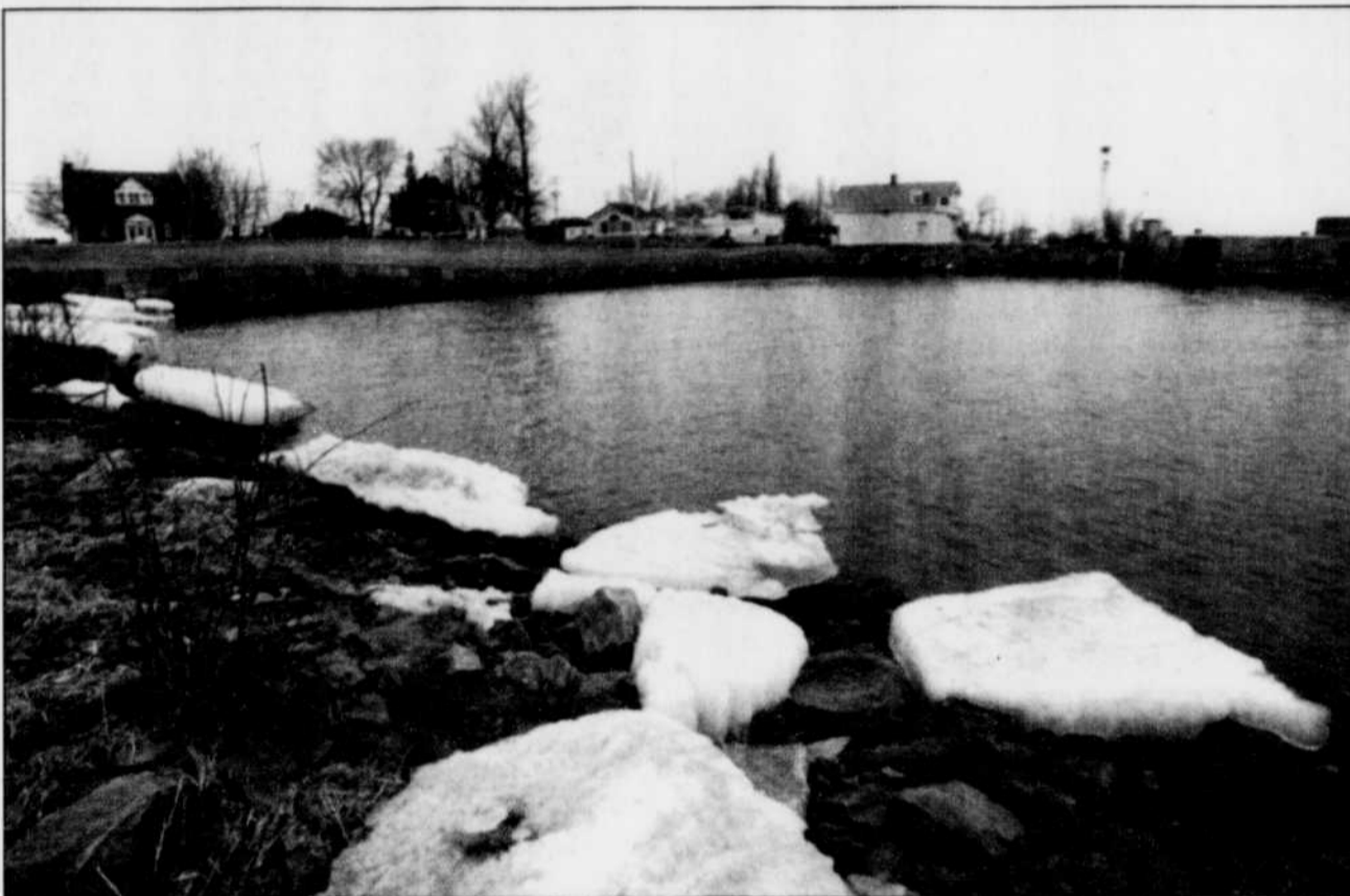
(Image-Média: Patrick Beauchamp) La municipalité de Batiscan a entrepris des démarches pour acquérir, d'Océans Canada, le quai fédéral. Elle entreprendra la construction, dès l'été, d'une rampe de mise à l'eau pour les embarcations de plaisance, à l'ouest du quai.
