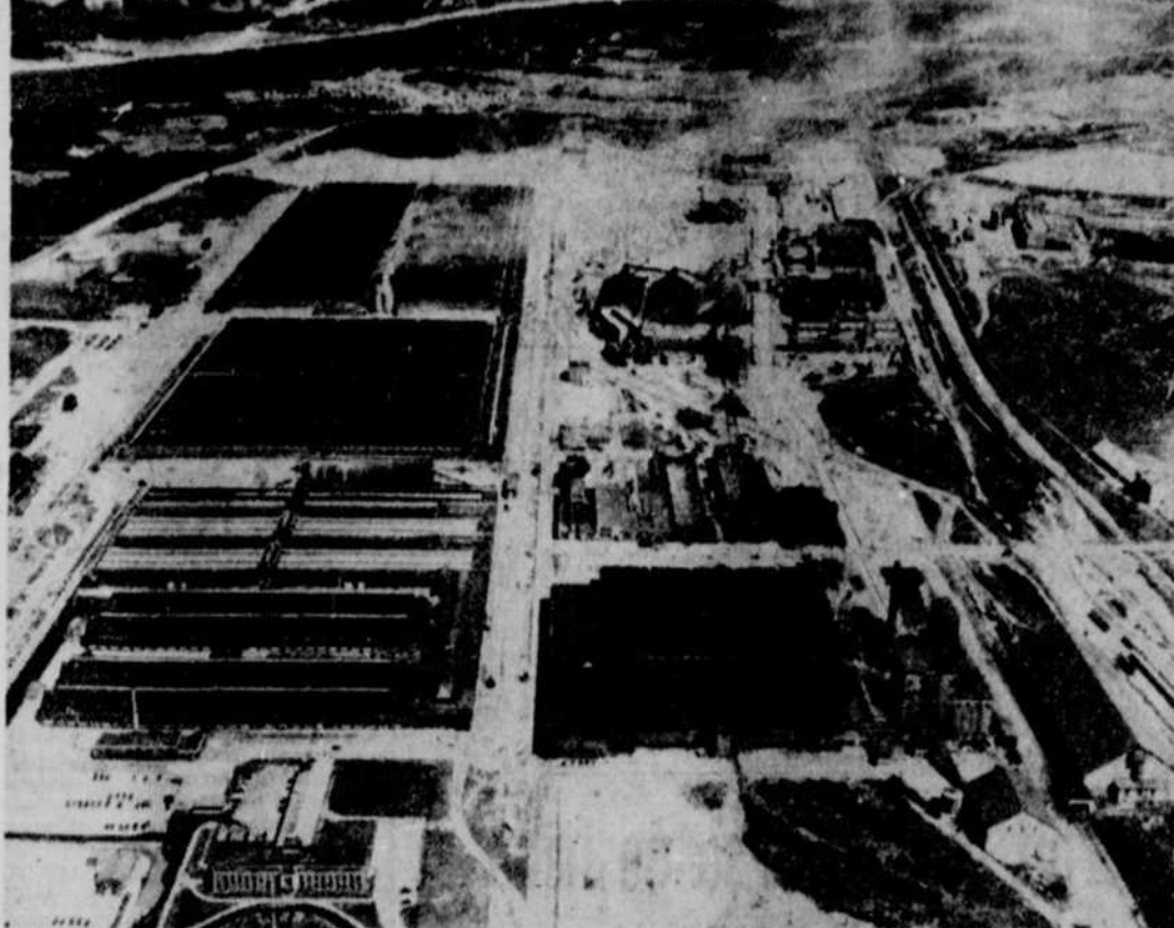
● C'est dans la province de Québec qu'elle se trouve, plus précisément à Arvida. Cette usine, dont on voit ici une photographie aérienne, mesure un mille de longueur par un demi-mille de largeur. A l'arrière-plan, le Saguenay, dont les eaux fournissent les millions de chevaux-vapeur nécessaires pour transformer la bauxite en aluminium. L'énergie hydroélectrique produite par les eaux du bassin du lac St-Jean dans leur course vers le fleuve et l'océan constitue la grande richesse de cette région. C'est à elle qu'il faut attribuer l'essor industriel du royaume du Saguenay. (Acme)
