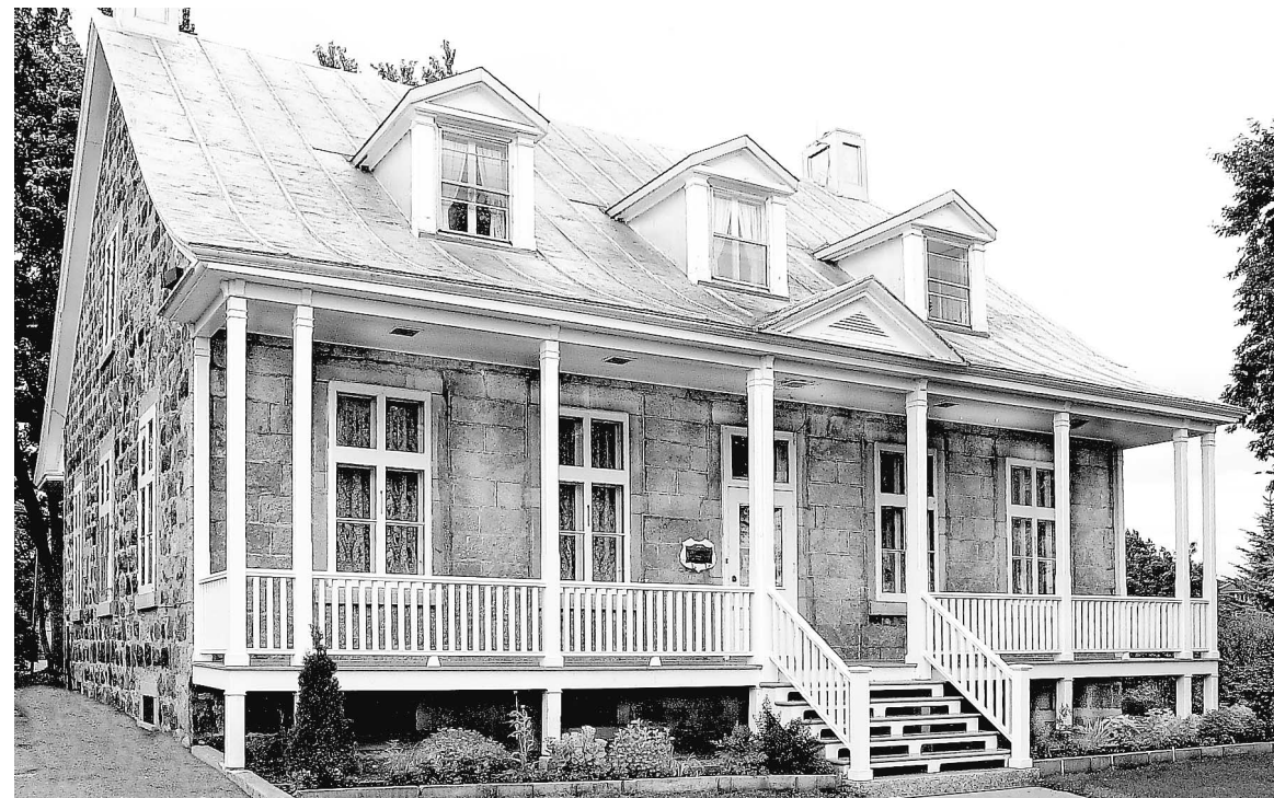
La grande galerie du presbytère Saint-Joseph de Rivière-des-Prairies a été construite l'an dernier, reproduction fidèle de celle de 1900.
