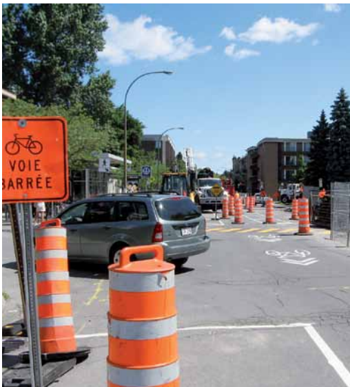
Travaux de réhabilitation des conduites d'eau potable réalisés cet été en prévision du réaménagement de l'avenue Laurier.
