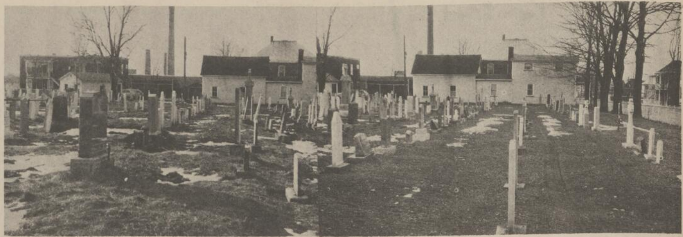
LES TRAVAUX DE REFECTION progressent, au cimetière de la rue Cowie. Les photos juxtaposées ci-haut montrent la différence qui existe entre le cimetière tel qu'il était auparavant (à gauche) et un secteur réaménagé, où la pelouse repoussera au printemps (à droite). C'est à l'honneur de chaque famille et à l'honneur de tous les citoyens de bien entretenir les terrains où reposent leurs parents et amis. Mais les prix modiques exigés autrefois pour l'entretien des lots rendaient impossibles les travaux requis pour maintenir le cimetière en bon état. Heureusement un appel
