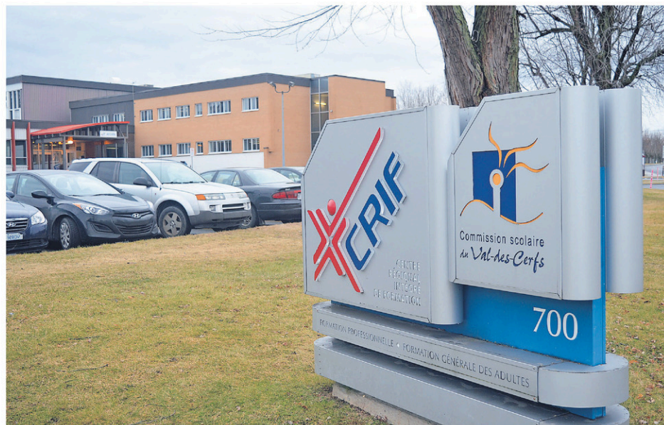
La réfection de la majeure partie de la toiture du CRIF nécessitera des investissements de 650 000 $. (Photos: Granby Express – Archives)
