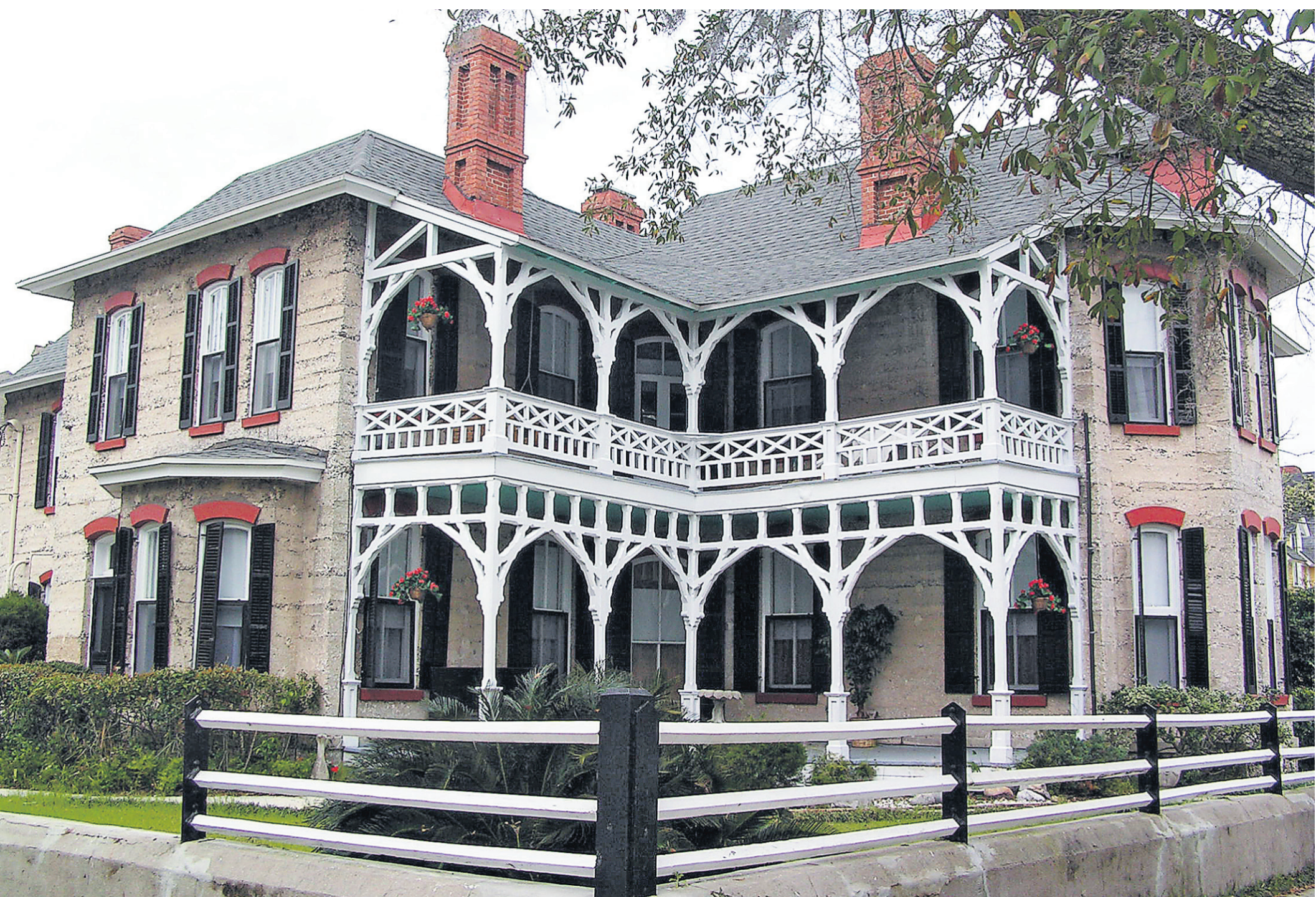
Le revêtement extérieur de la Tabby House (1885) est fait de ciment et de coquilles d'huîtres concassées.
