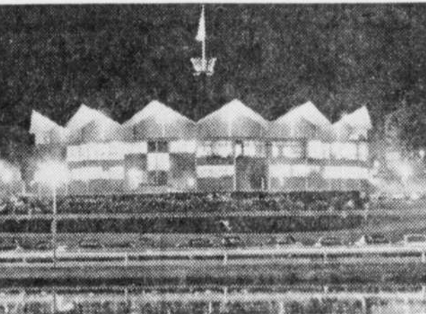
L'édifice qui a remplacé la tente du festival, à Stratford.
