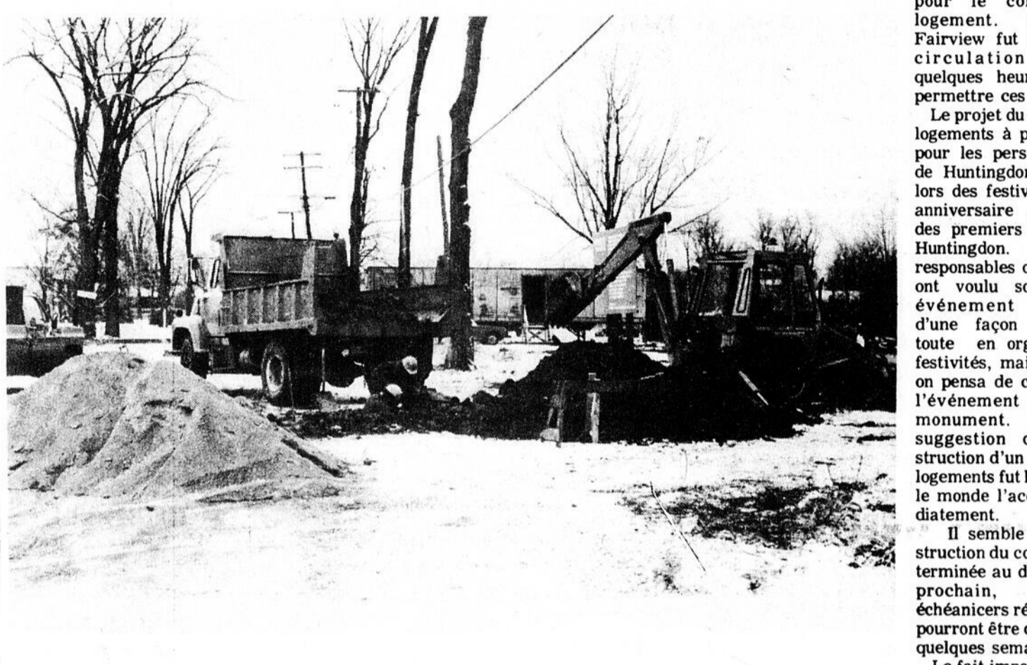
Les employés municipaux de Huntingdon ont travaillé à cet endroit le 5 décembre dernier afin de poser la conduite d'eau vers ce nouveau complexe de logements.
