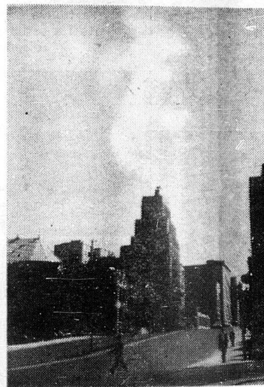
Les nouvelles perspectives du boulevard Métropolitain. On construit, depuis plusieurs années, de nouveaux édifices.
