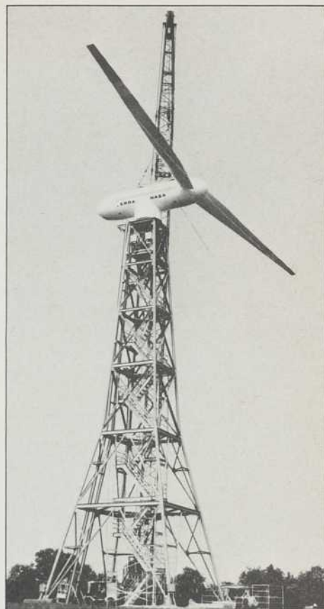
Cette éolienne, mise au point par l'Energy Research and Development Administration, est installée à Lewis' Plum Brook Station. Les deux pales ont une envergure de 38 mètres et sont montées sur une tour de 30 mètres de hauteur. Elle est d'une puissance de 100 kilowatts.
