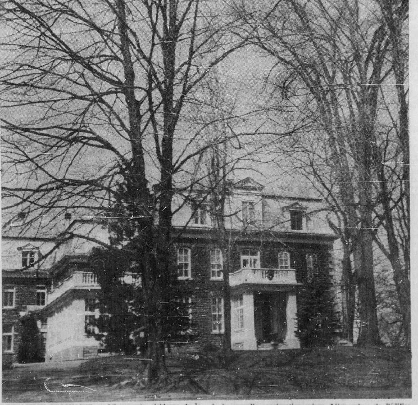
DEMOLITION PROCHAINE — L'imposante résidence de la Délégation apostolique, 520 Driveway, dans la capitale, cédera bientôt sa place à un nouvel édifice plus spacieux et contenant des locaux plus appropriés aux besoins. Construite vers 1875, elle sera livrée au pic du démolisseur dès juin prochain. Cette première étape terminée, la mise en chantier de la nouvelle construction suivra. L'âge même de l'édifice qui trahit certaines faiblesses dans la charpente et les fondations aussi bien que l'exiguïté des pièces sont les raisons qui militent en faveur de la démolition de cette magnifique demeure dont huit représentants du Saint-Siège ont été successivement les hôtes. (Voir nouvelle en page 5.) (Photo Champlain Marci)
