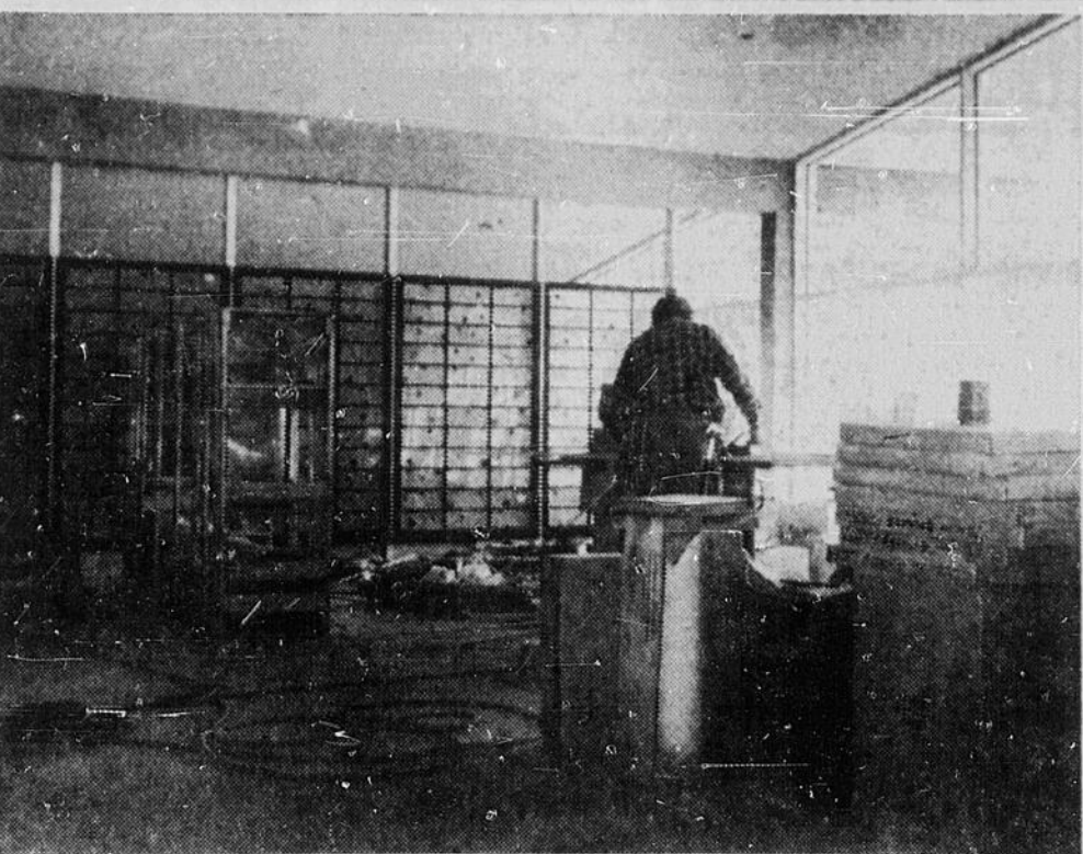
TRAVAIL DE FINITION — Le Foyer des vieillards de Sturgeon Falls sera bientôt complété. Les ouvriers y travaillent avec diligence et on est à mettre une dernière main aux travaux de peinture, etc. La photo nous fait voir une partie de la cuisine où on est à faire les dernières retouches. L'architecte, M. Lucien Déleau et les entrepreneurs en construction Taillefer se disent très satisfaits de ces travaux de construction. On prévoit que ces travaux seront terminés à la fin du mois de mai.
