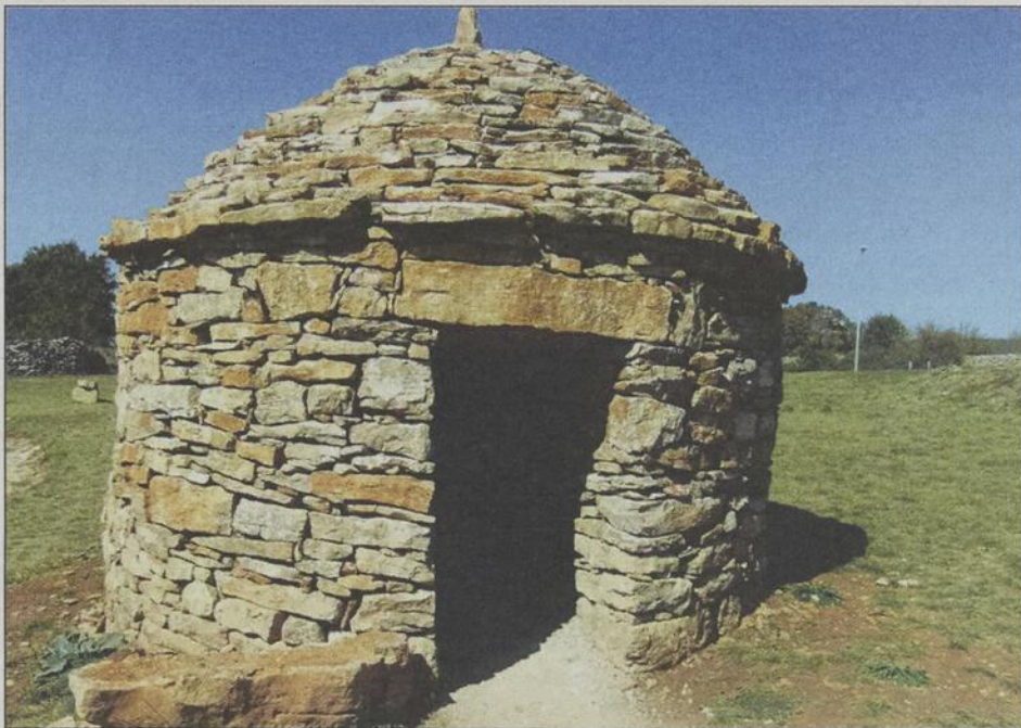
Toujours construite en pierre sèche, matériau trouvé sur place, la caselle servait de refuge au berger.
