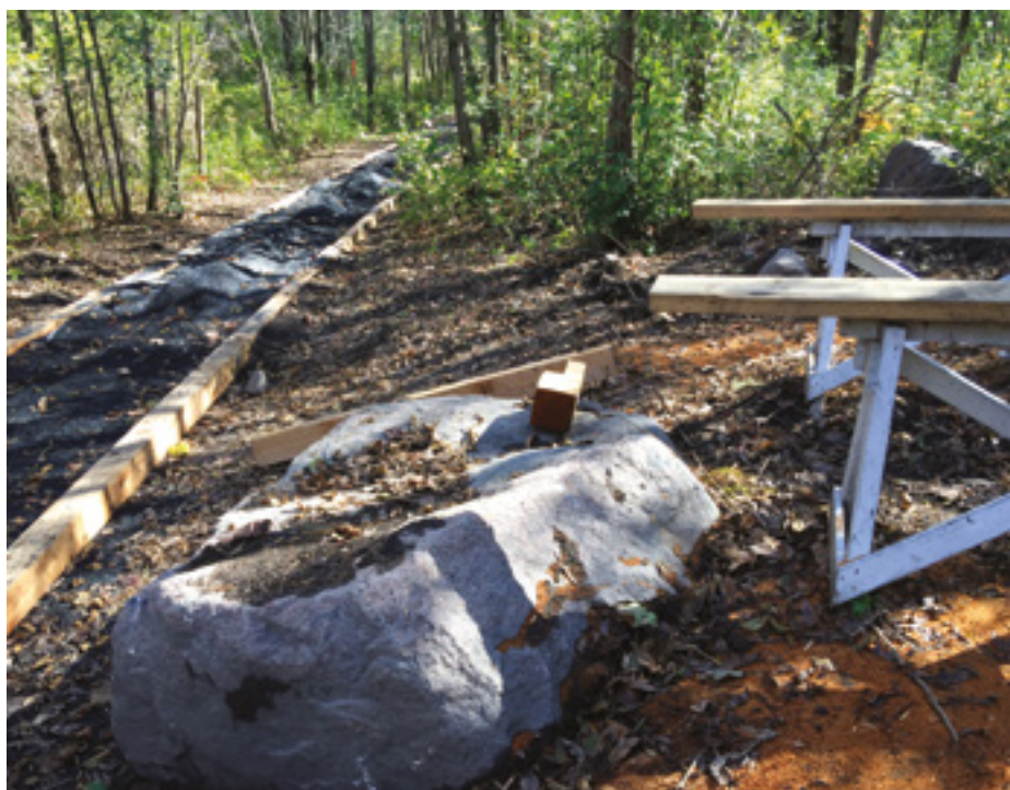
Sentier en construction, boisé Du Tremblay
