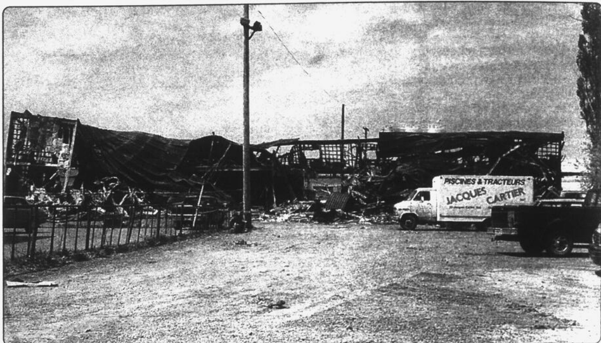
L'incendie a été sans pitié pour Piscines Jacques-Cartier. Le bâtiment est une perte totale.
