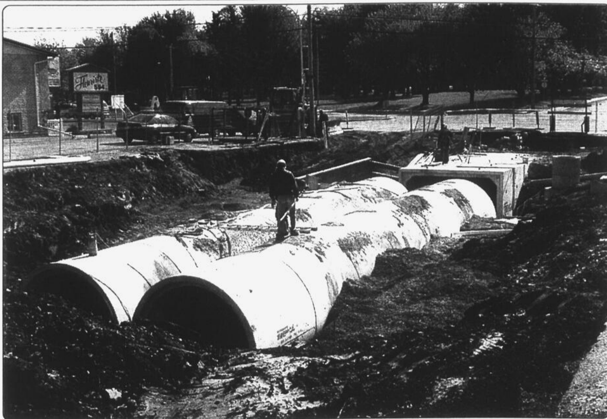
L'enfouissement de ces deux impressionnantes conduites d'égout pluvial rendait inévitable la disparition des arbres de la rue Latour qui seront tous remplacés à la fin des travaux.
