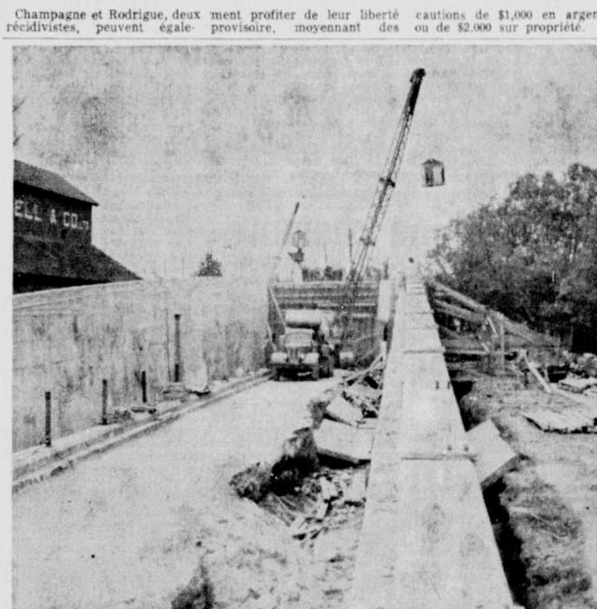
Coulage de béton. — Des ouvriers ont coulé hier 275 verges de béton sur le tablier de la culée sud du pont des Grandes-Fourches, près de la rivière Magog. Le tablier mesure 95 pieds de longueur et 32 pieds de largeur. Comme le montre cette photo, le béton est placé dans un "bocket" et monté sur le tablier par une pelle mécanique. La circulation a dû être interrompue temporairement sur la voie à sens unique de la rue des Grandes-Fourches. (Photo La Tribune, par Studio Breton)
