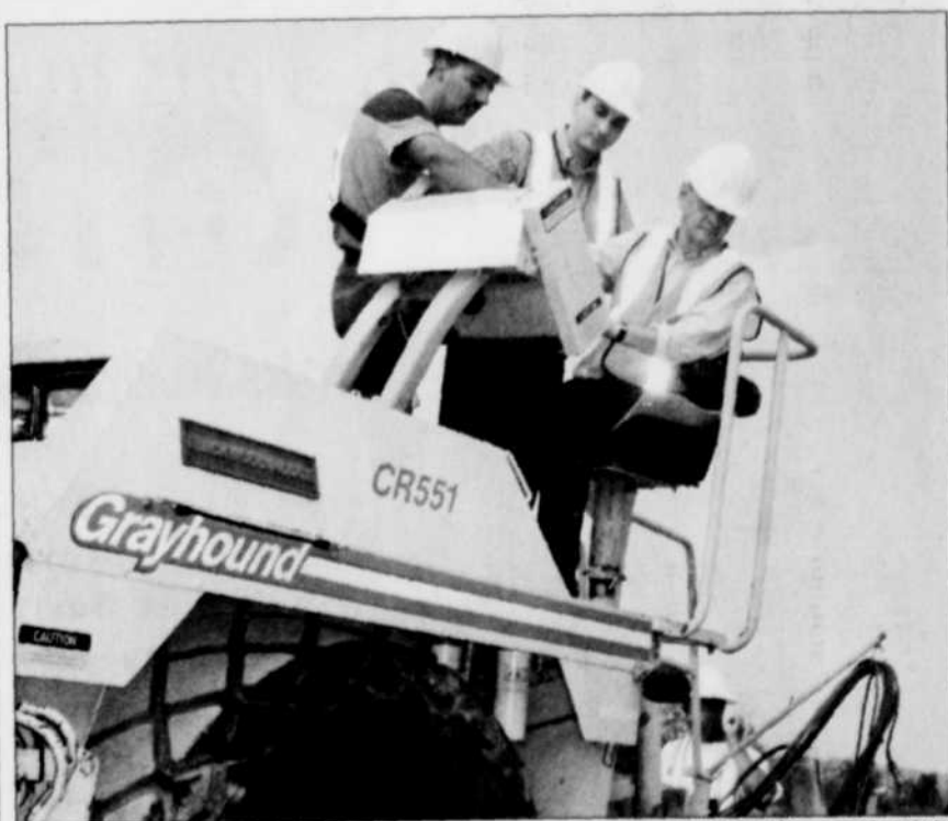
Les premiers ministres Chrétien et Lord ont tâté de la machinerie lourde, hier, en annonçant la mise en marche du chantier de la route 185.
