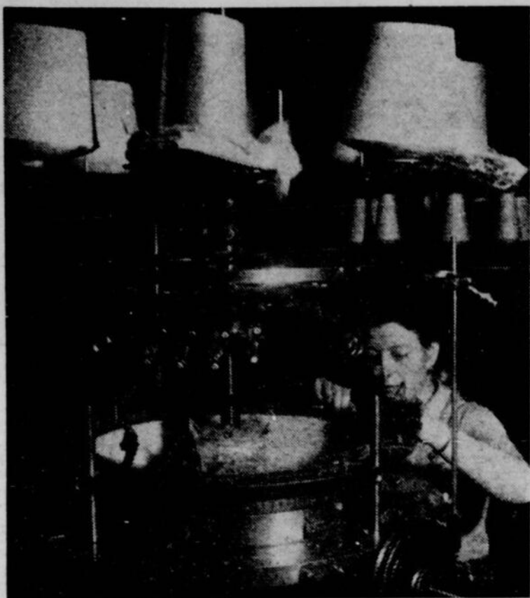
Evidemment, les chandails sont faits mécaniquement, précisément par cette machine, qui compte exactement 960 aiguilles à tricoter !
