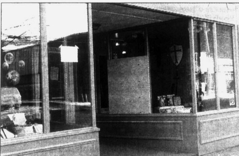
Imitant ses voisins, le Draconome a lui aussi choisi la feuille de contreplaqué pour réparer une fenêtre cassée.
