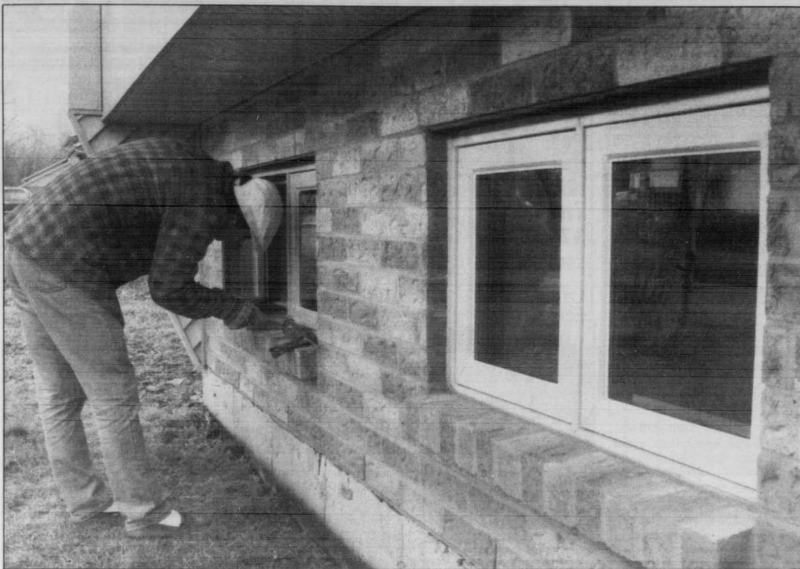
Pour bien se préparer à l'été, une maison demande un minimum d'entretien. Vérifiez notamment le calfeutrage autour des fenêtres, l'état des margelles et des gouttières.
