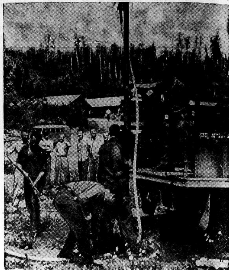
Méthode bizarre mais rapide de creuser un puits. Cette foreuse utilise un jet d'eau pour percer le trou qui permettra d'enfoncer un tuyau jusqu'à la nappe d'eau souterraine. C'est en quelque sorte une seringue. On peut ainsi trouver de l'eau assez rapidement en cas d'urgence.
