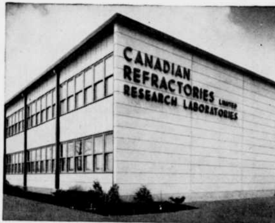
C Ici on a utilisé des panneaux de béton légers pour réduire le temps et le coût de la construction.
