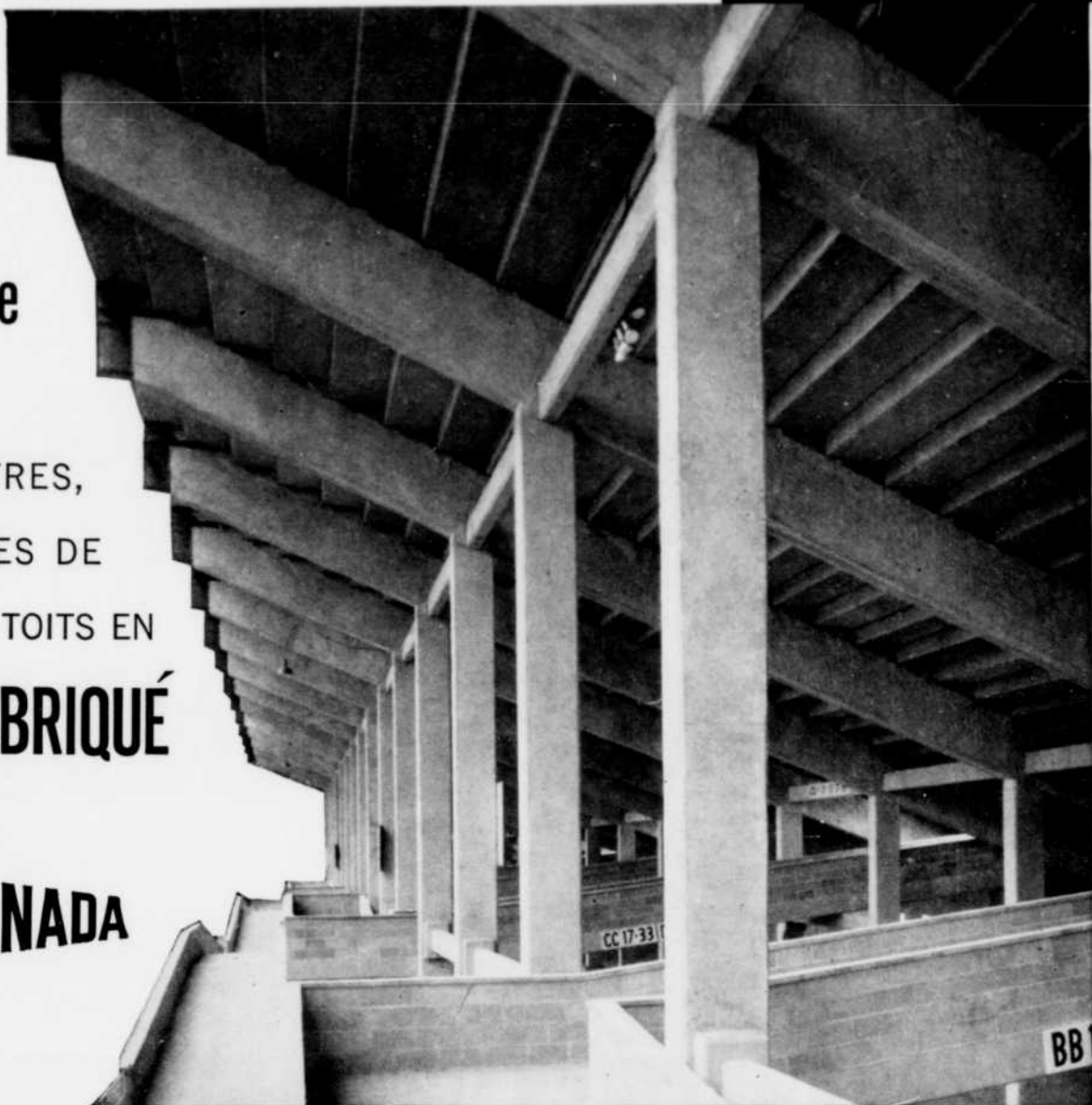
F Pour accélérer la construction, ces pièces de charpente en béton préfabriqué furent fabriquées avec du ciment "Canada" de type Portland XXX à haute résistance initiale.
