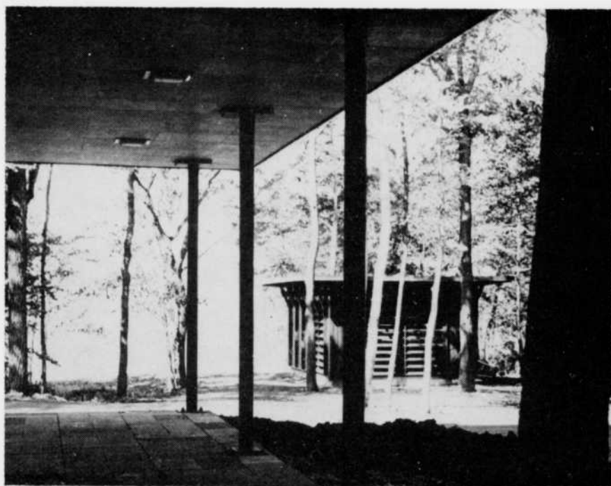
Fig. 3 — Poste d'oxydation totale à proximité de la maison de retraite des Soeurs de Sainte-Croix, à Pierrefonds.
