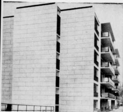
B Maison d'appartements entièrement construite en béton.
