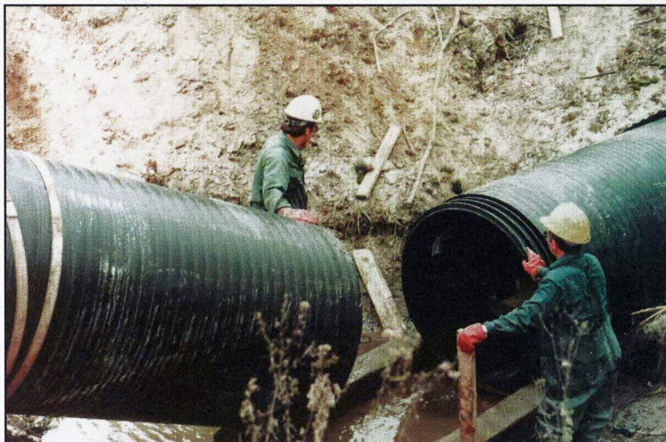
Réhabilitation par insertion d'un Weholite 42" à l'intérieur de 450 pi de tuyau en tôle ondulé corrodé de 54". Projet MTQ, autoroute 640 à Ville de Lorraine réalisé en 6 heures.
