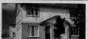
216, Place des Sorbiers, Hull - Joli condo au dernier étage de 2cc. Plancher flottant et de céramique à la grandeur. Très propre, air climatisé mural, grand balcon. Situé près des écoles et CEGEP. Libre immédiatement. Frais de condo de 1275$ par mois inclus le câble. Sylvie Perreault 778-9002 - 1070005 (028055)
