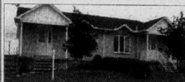
128, du Sauvignon, Masson-Angers - Superbe semi combe neuf. Fenestration en P.V.C. Plafond cathédrale au salon. Armoires en mélamine grain de bois. Plancher de bois franc au salon. Division pour une troisième chambre au s/s. Faites vite. Jean-Yves Plouffe 99 9005 (028175)
