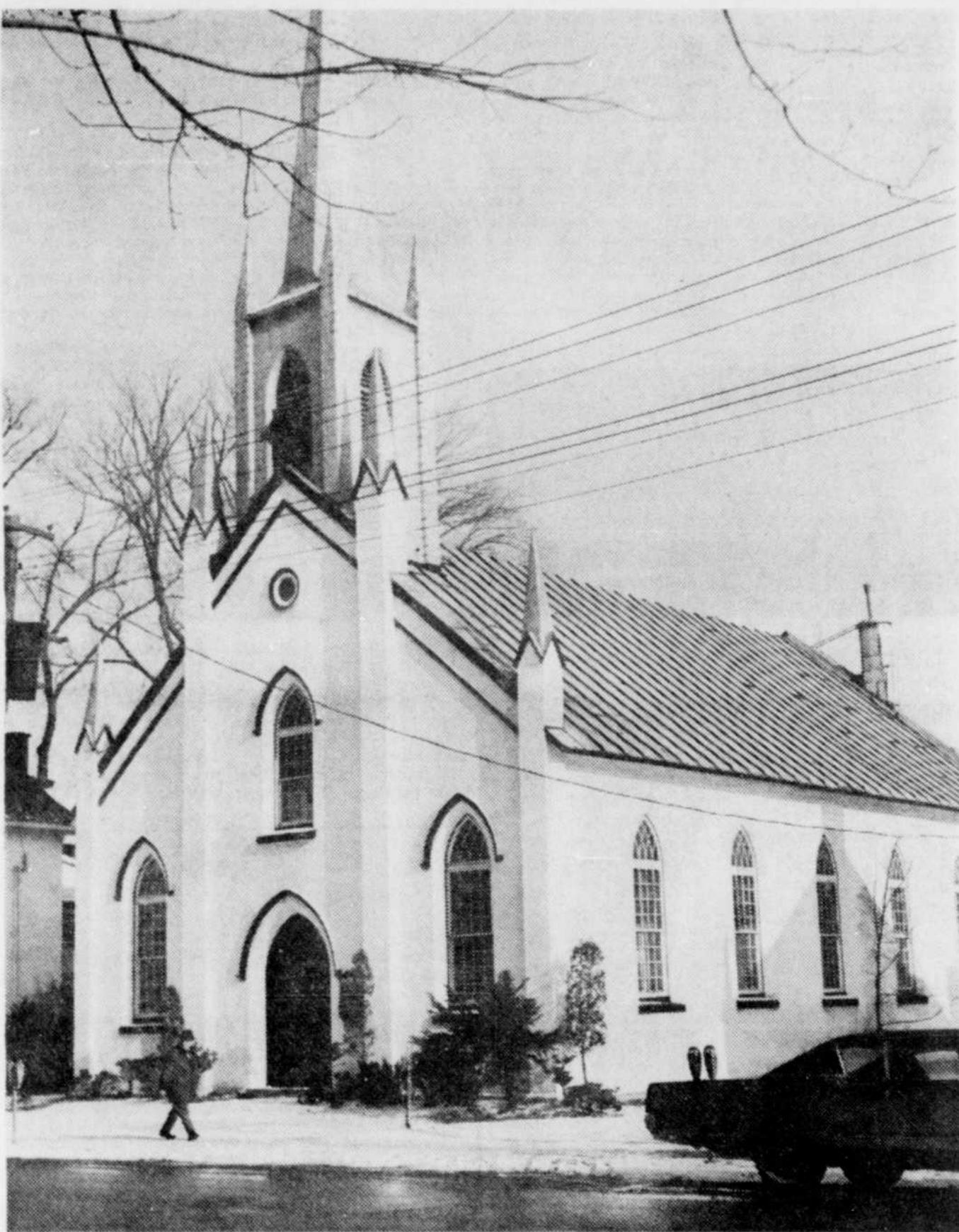
L'ÉGLISE ANGLICANE Christ Church, située sur la rue du Prince, face au Carré Royal, à Sorel, recevra une subvention de $5,000 du ministère des Affaires culturelles, de qui relève la Commission des Sites et Monuments historiques du Québec. Cette église a été reconnue comme monument historique il y a quelques années. Le présent octroi servira à défrayer le coût des réparations à la toiture de même qu'à l'intérieur de l'église.
