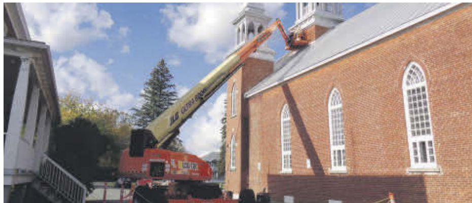
Des travaux urgents ont été réalisés sur la maçonnerie du clocher et des murs extérieurs de l'église de Sainte-Victoire. Photo gracieuseté
