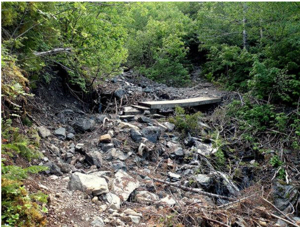
Figure 1. Dégât causé par la forte crue de l'été 2009. Le pont d'origine a été remis en place bien qu'on réalise sa sous-capacité leur des crues torrentielles. (Photo B.Vigneault)
