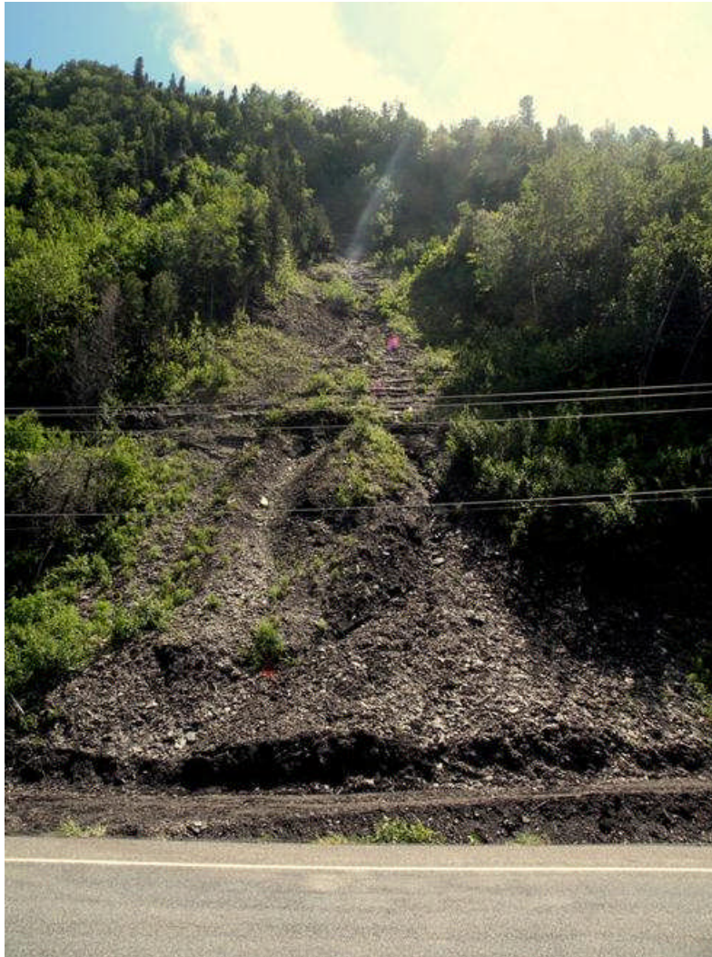
Figure 1. Glissement pelliculaire le long de la route 132. (Photo B. Vigneault)
