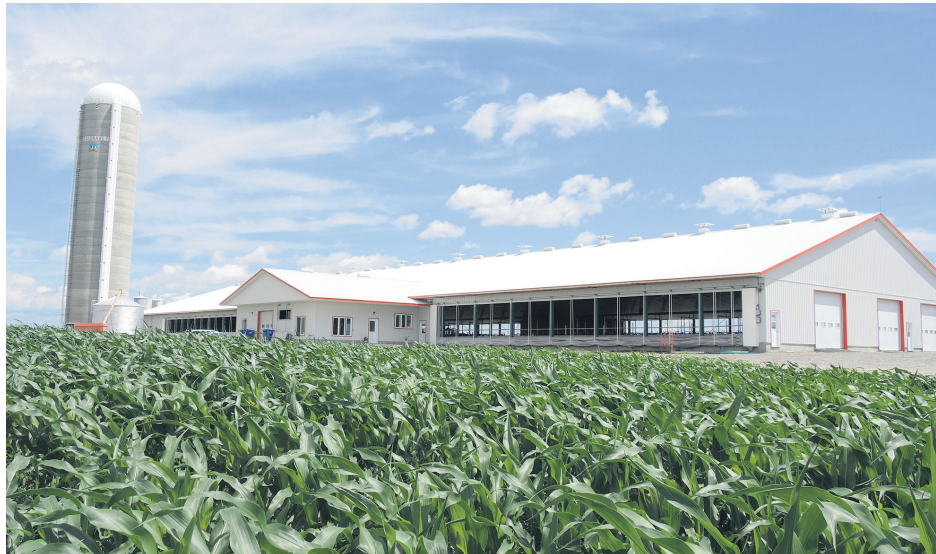
La famille a reconstruit la ferme, moins d'un an après l'incendie. (Photo : Annabelle Baillargeon)
