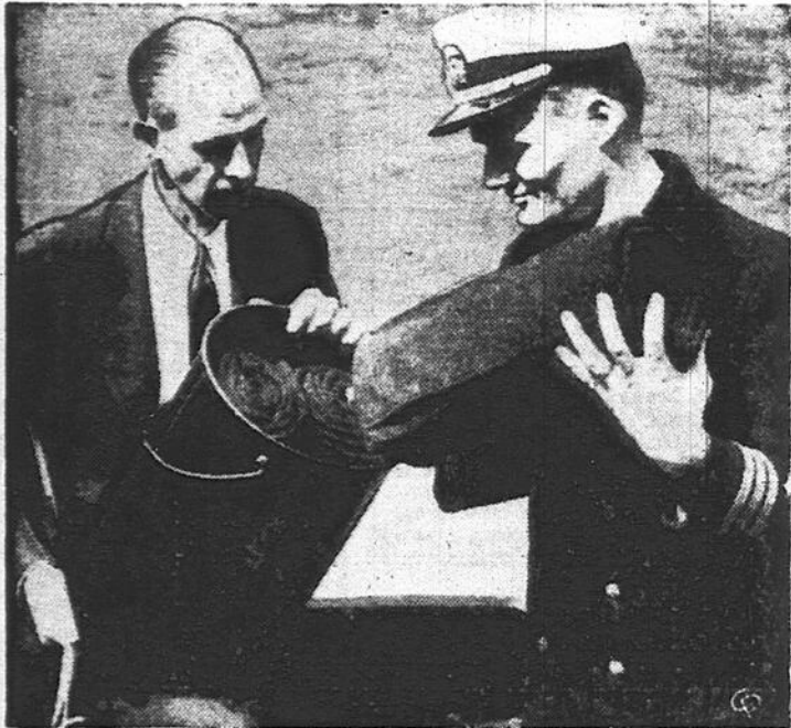
Voici des couvertures en conserves! La boîte est spécialement fabriquée par American Can Company pour le compte de la Marine américaine. George Eckman, ingénieur-dessinateur, tient la boîte tandis que l'officier commandant Allan-C. Smitles, d'un navire marchand américain, en sort l'une des couvertures. Le contenant peut servir de récipient d'urgence pour l'eau potable.
