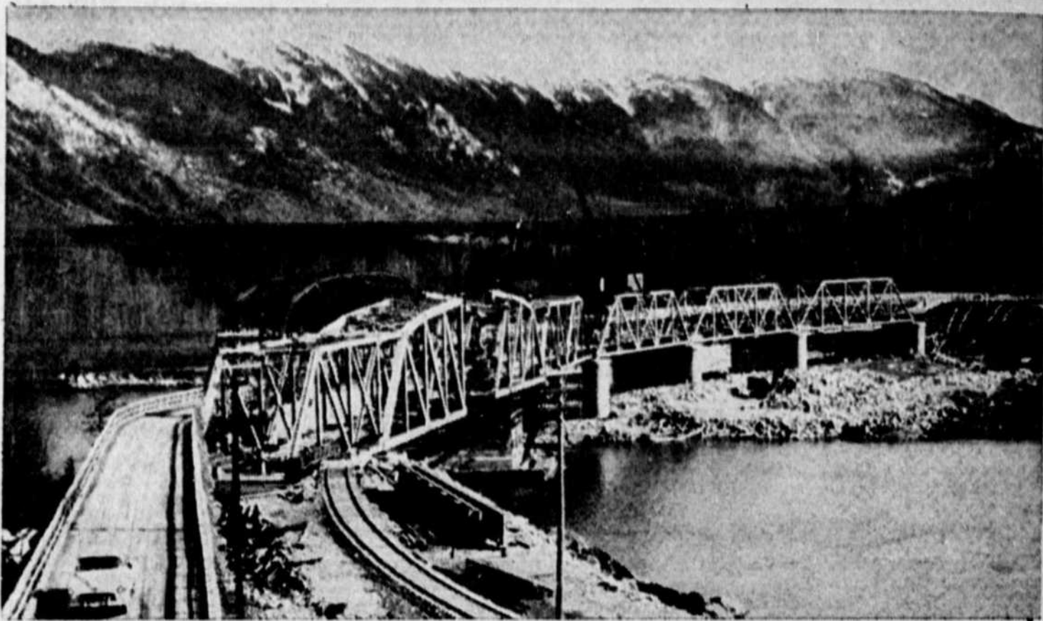
UNE CONSTRUCTION VITALE — Cette construction, actuellement en cours à Kitimat, en Colombie britannique, ne sera pas qu'un pont ferroviaire servant à faciliter le transport des matériaux et des hommes. Elle tiendra un rôle vital dans cette région où l'on exploite la production de l'aluminium, un développement d'ailleurs récent à Kitimat. Cette région montagneuse sera en même temps d'un accès facile aux convois du Canadien National. On voit ici que le travail des ingénieurs consiste à ajouter sa septième partie au nouveau pont qui traversera la rivière Skeena, laquelle longe sur presque toute sa longueur cette importante région offerte au développement de l'aluminium.
