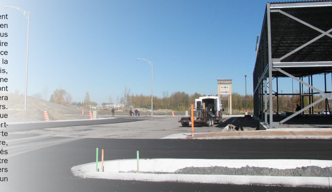
Le prolongement de la rue Hains en voie de réalisation
