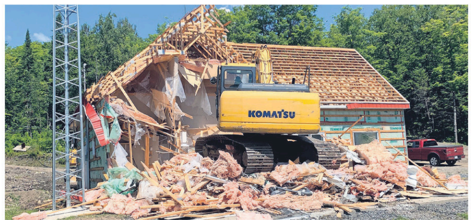
À la suite d'un déversement, l'Érablière du lac Wallace a dû entreprendre des travaux de décontamination, ce qui a entraîné la démolition de son bâtiment principal. (Photo gracieuseté)
