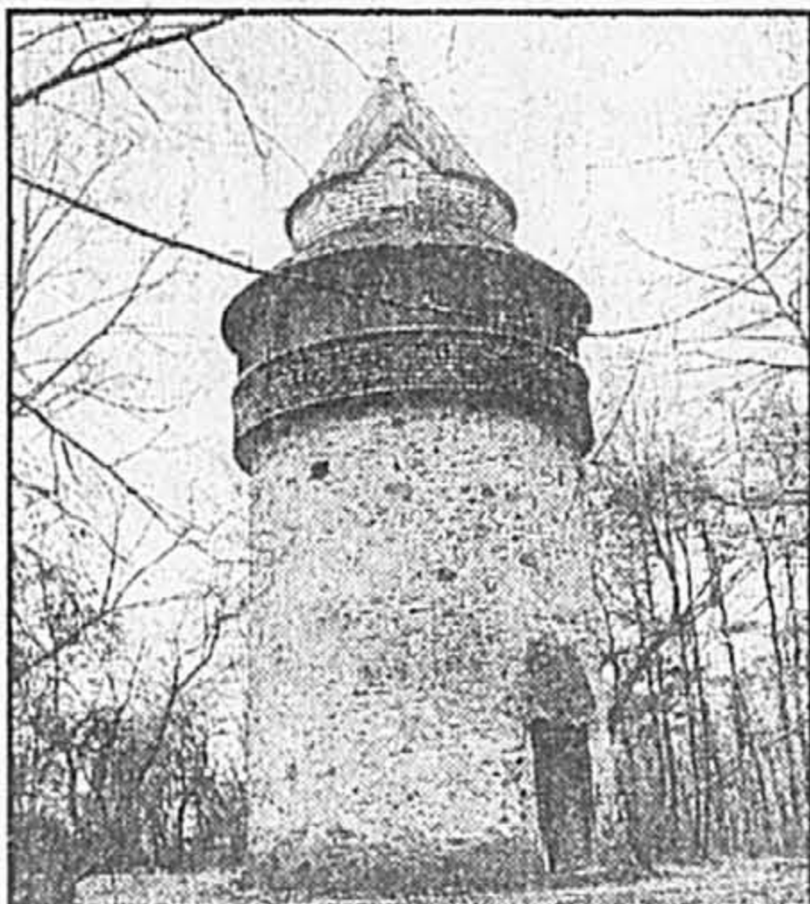
La face sud du moulin. L'angle est le même que celui de la photo d'antan.
