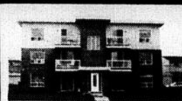
3-VOILÀ un bon placement. 6 logements de 5 1/2 pces. Plancher béton. Porte coupe-feu. Grand stationnement. P.-Émile Rousselle 348-1186.
