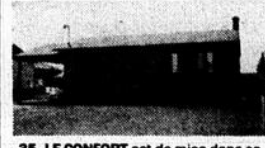
35-LE CONFORT est de mise dans ce bungalow conts. 84. Bien éclairée avec des fenêtres manivelles. Arm. culs. en chêne. Michel Longpré 348-1186.
