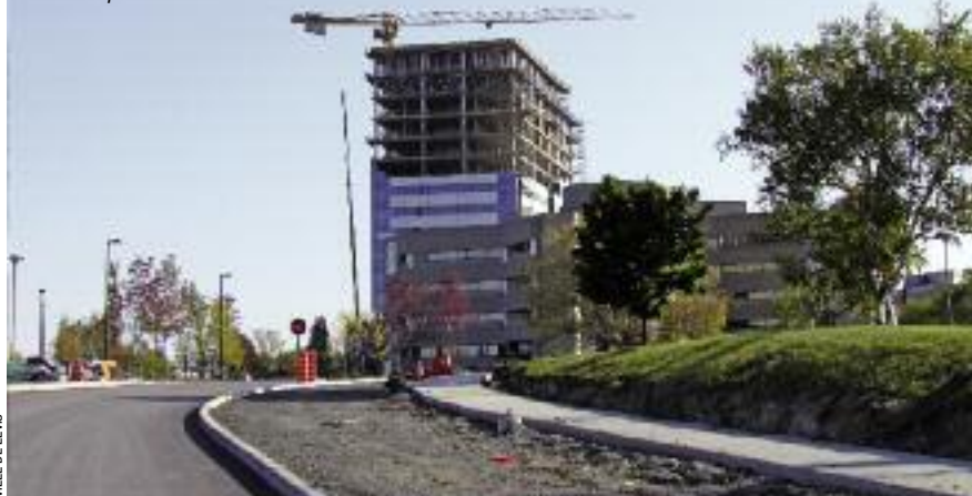
Tour en construction dans la Cité Desjardins de la coopération.
